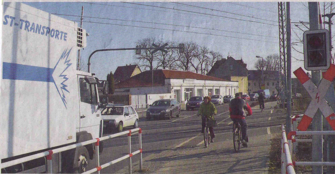
Der Bahnübergang Berliner Straße wird nach 2016 kein Hindernis mehr sein.
