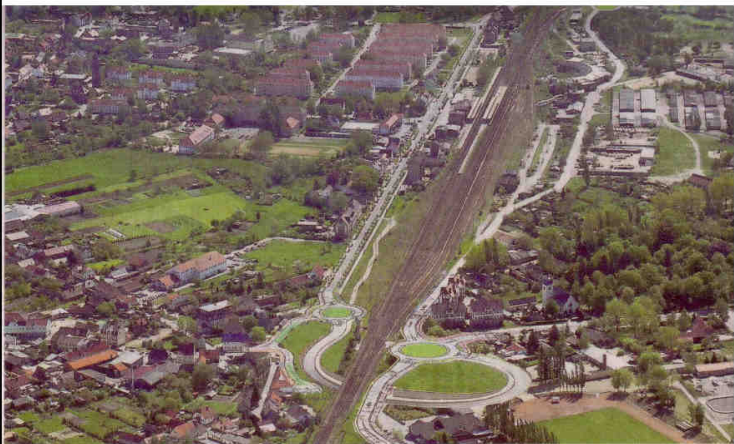
Die Umbauten mit dem Nordkopf Straße des Friedens/Berliner Straße (unten), dem Südkopf an der L 49/Kraftwerkstraße und der künftigen Landesstraße auf der Güterbahnhofstraße (rechte Seite).
